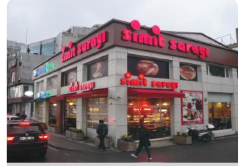
SEYRANTEPE ÇELİK BİNA SEYRANTEPE STEEL BUILDING
